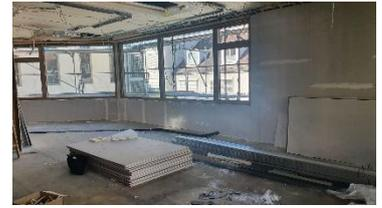
Nun sind die Trockenbauer an der Reihe und bringen Rigipsplatten an die Wände. Als Nächstes wird die Dämmung für den Estrich und der Estrich verlegt, sodass wir uns demnächst dem Innenausbau widmen können.
